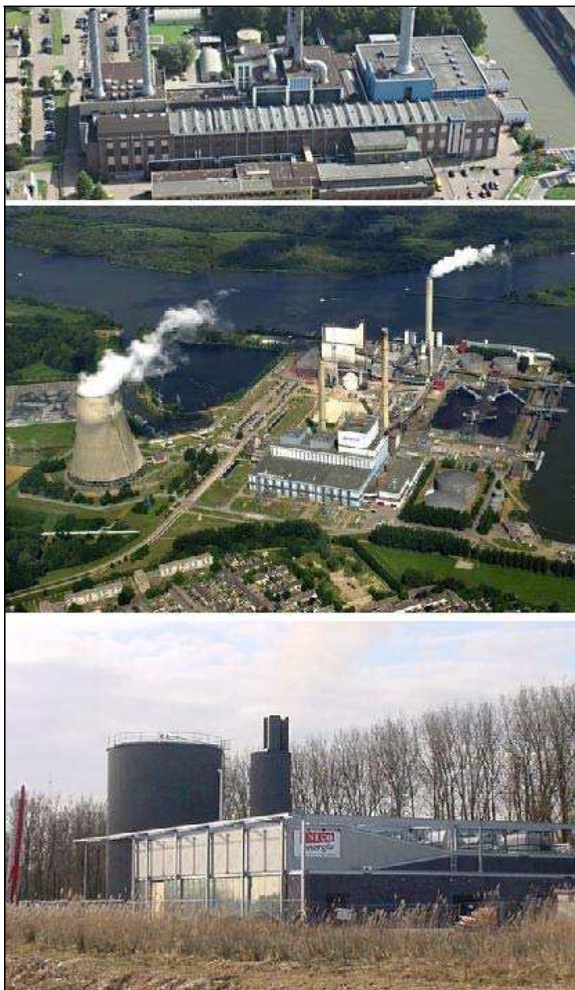
Opmerking: Merwede Kanaal, Nuon (boven); Amercentrale, Essent (midden); WKC Ypenburg, Eneco (onder).
